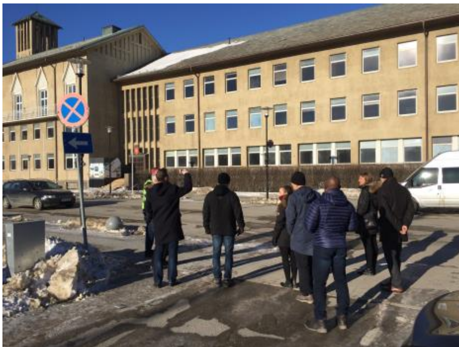
Fasaden på det gamle rådhuset, som innvendig er strippet og klargjort for bygging
